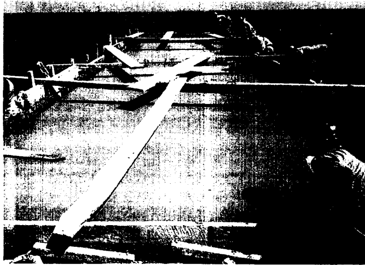
FOTO 09: Vaciado de concreto F'c = 280
