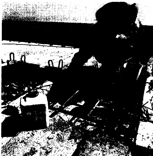
FOTO 02: Aplicación de transformador de óxido en acero
