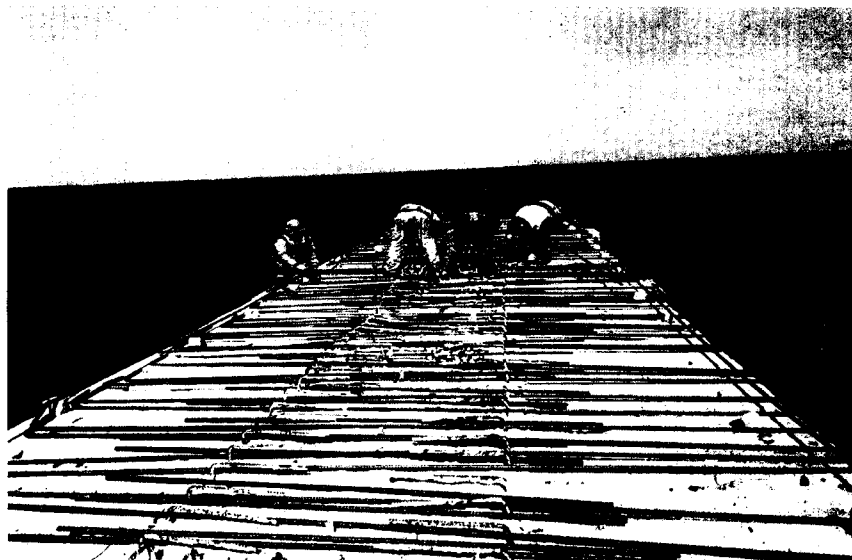
FOTO 05: Acarreo de acero para el armado estructural en losa
